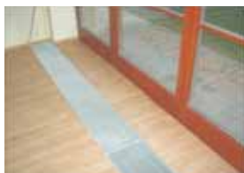
Nekvalitní provedení detailu spodní hrany prosklené stěny. Foto: David Lukavec, EkoWATT
