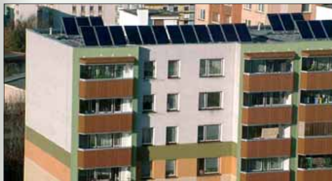
Instalace solárního teplovodního systému na střechu panelového domu. (Zdroj: BD Orlová)
