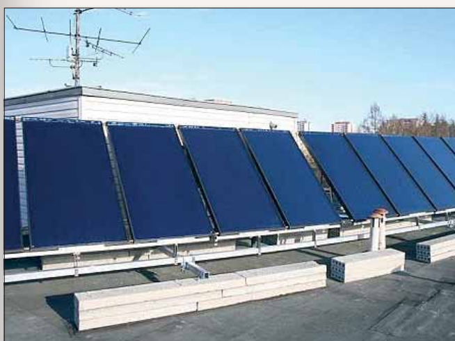
Umístění solárních kolektorů na střeše. (Zdroj: BD Orlová)
