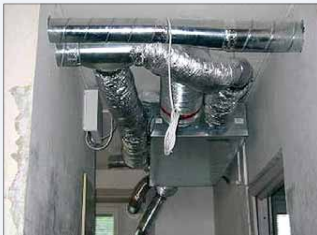
Průběh instalace lokální rekuperační jednotky v bytě. Jednotka bude ve finálním provedení zakryta podhledem. (Zdroj: EkoWATT)
