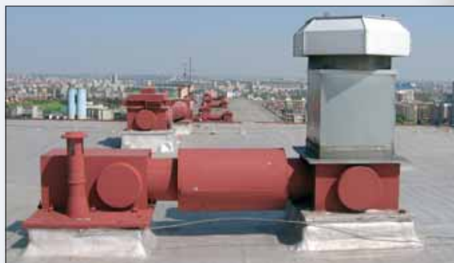
Centrální podtlakový ventilátor – současné obvyklé, avšak nedostatečné řešení větrání panelových domů. (Foto: EkoWATT)
