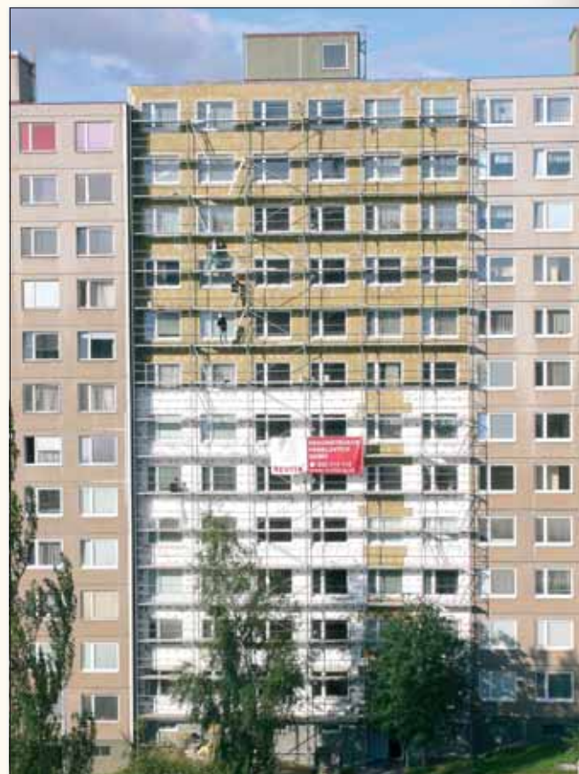
Použití různých tepelně-izolačních materiálů při zateplování panelových objektů. (Zdroj: EkoWATT)
