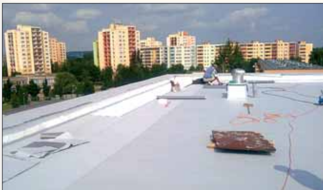
Realizace zateplení střechy. (Zdroj: EkoWATT)
