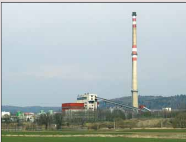
Teplárna Písek. (Foto: P. Brož)
