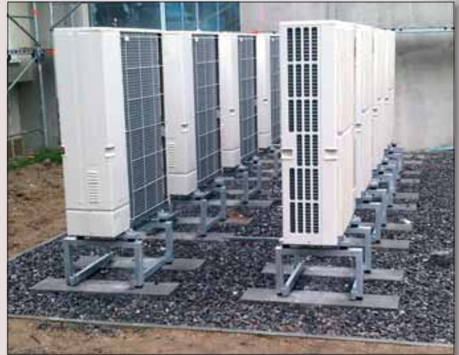
Kaskáda elektrických tepelných čerpadel vzduch – voda. (Zdroj: Tepelná čerpadla IVT)
